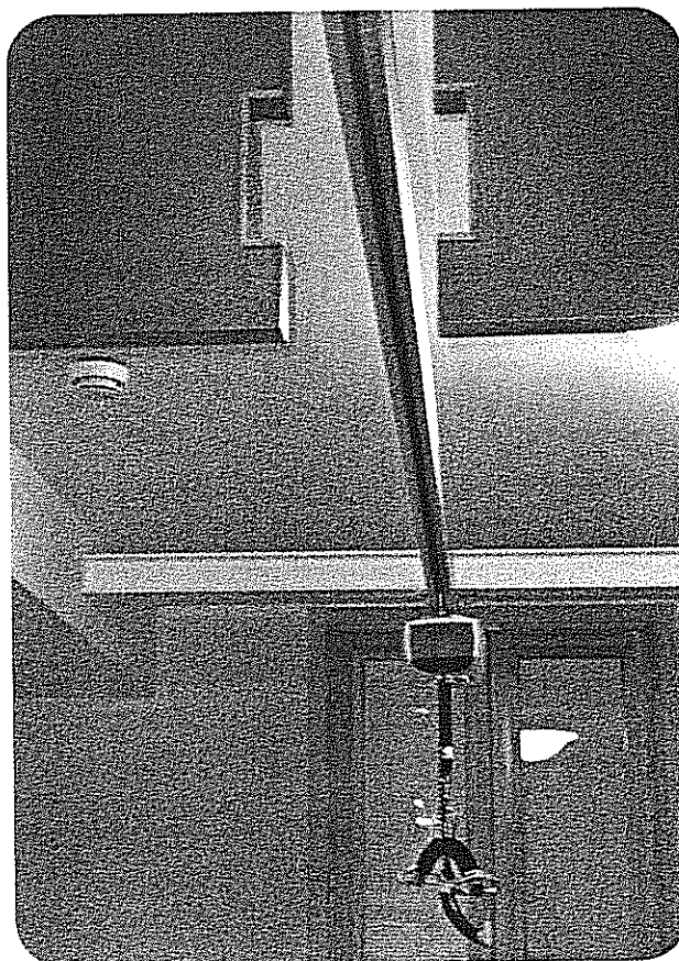
Fig. 2. Bologna, Corte Roncati, particolare del binario per sollevatore
