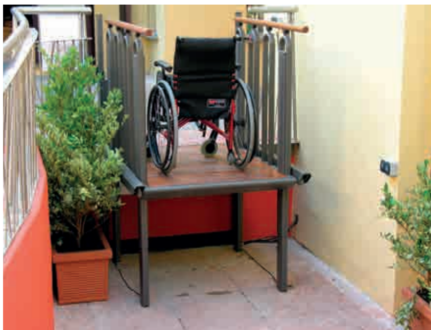
Foto 3 - Particolare scala accessibile
